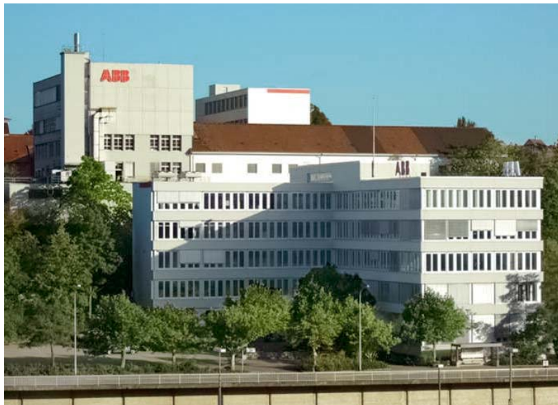
Le site de l'unité des produits basse tension ABB à Schaffhouse.
