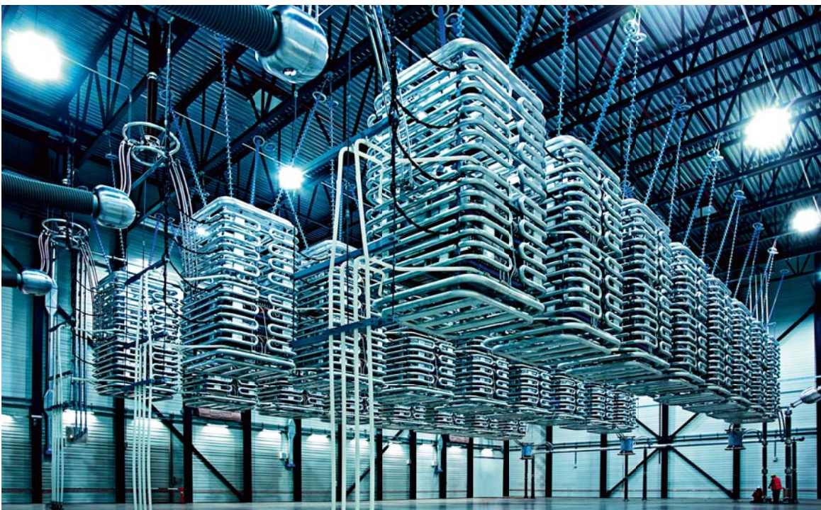
Atelier dans lequel du courant électrique est transformé avec des semi-conducteurs de puissance.
