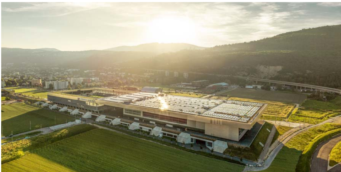
Des onduleurs ABB sont installés dans la centrale solaire sur le toit du stade Tissot à Bienne. L'intégration d'énergies renouvelables est un marché d'avenir.
