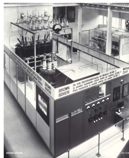
Poste de transformation de BBC sur l'exposition «Landi» en 1939.
