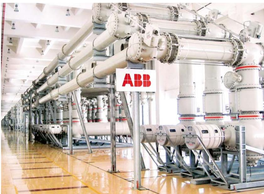
La plus grande installation de distribution isolée au  $\text{SF}_6$  sur le barrage des Trois-Gorges du Yangzi Jiang en Chine est conçue pour 550 kV.
