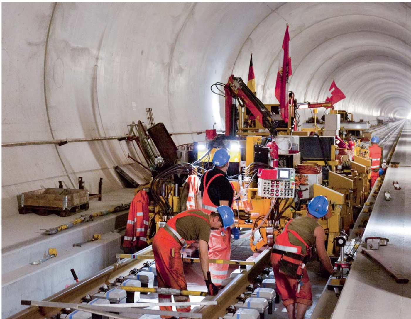
Les derniers travaux dans le tunnel de base de Saint-Gothard touchent presque à leur fin. Le compte à rebours avant l'inauguration est lancé.
