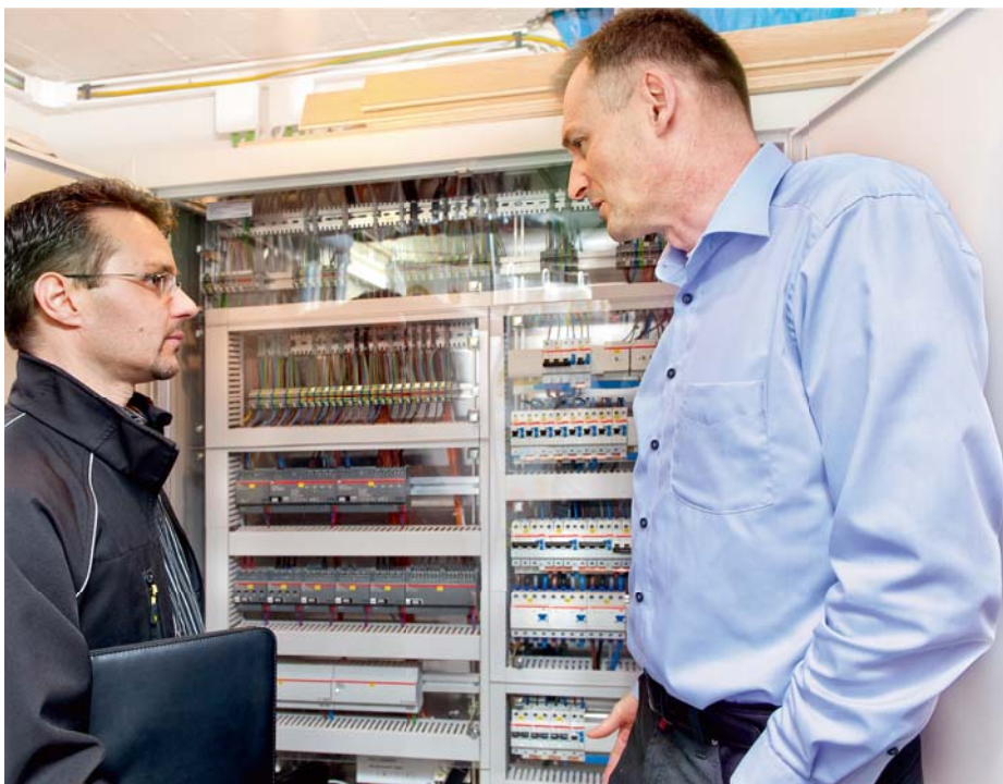
L'installateur électrique Roger Acklin (à gauche) en compagnie de Dieter Kunert devant l'armoire électrique au sous-sol.
