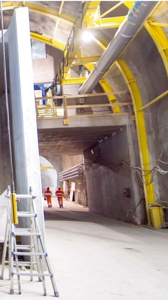
Un des énormes ventilateurs livrés dans la centrale de ventilation.
