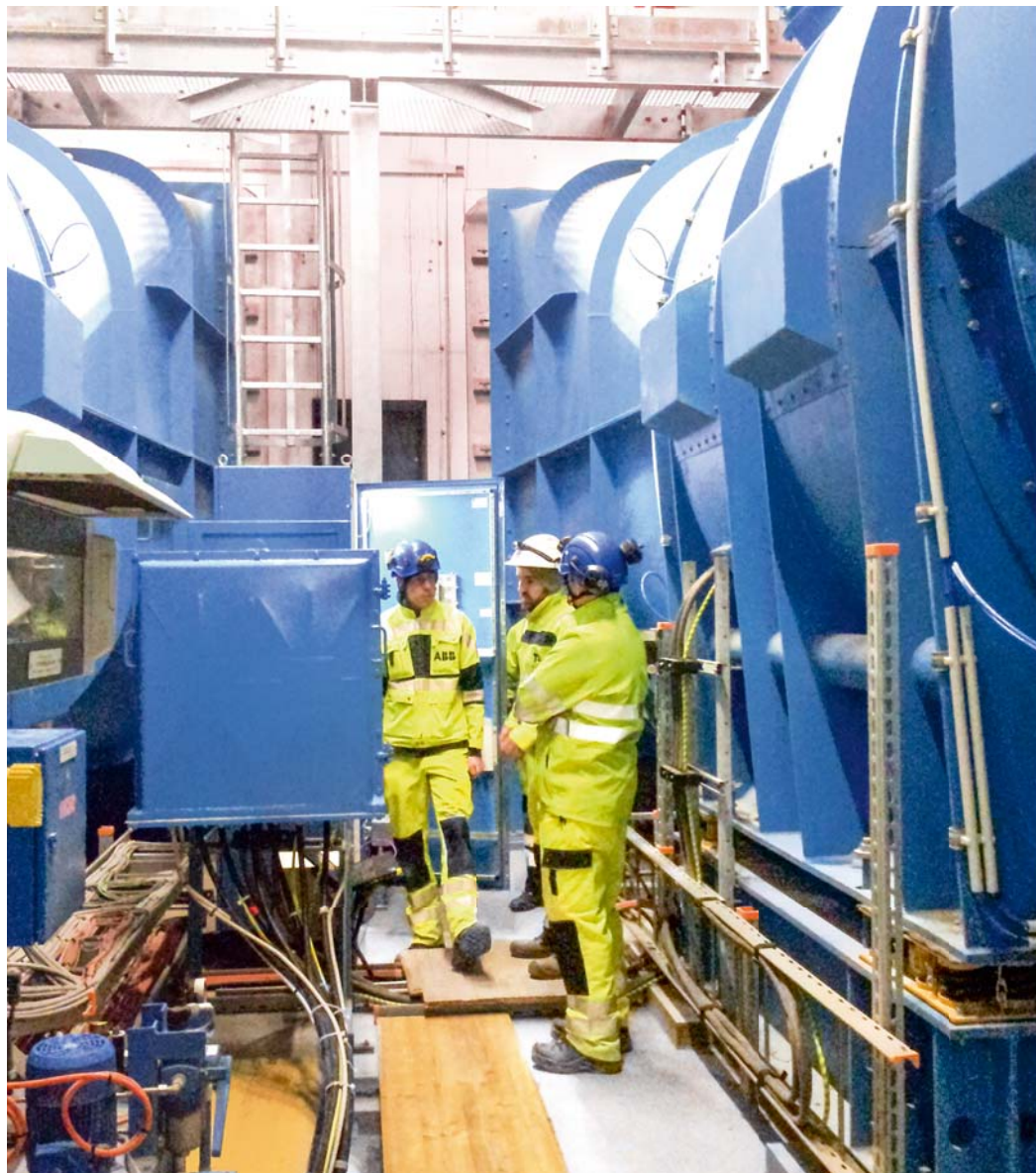
Des ingénieurs d'ABB auprès des ventilateurs d'une largeur de 3,5 m.
