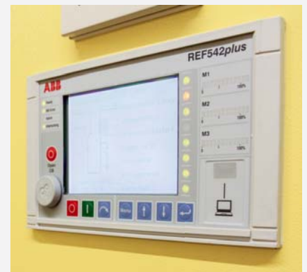
Un REF542plus parmi plus de 500 installés, ici dans une installation de commutation MT ZX0.
