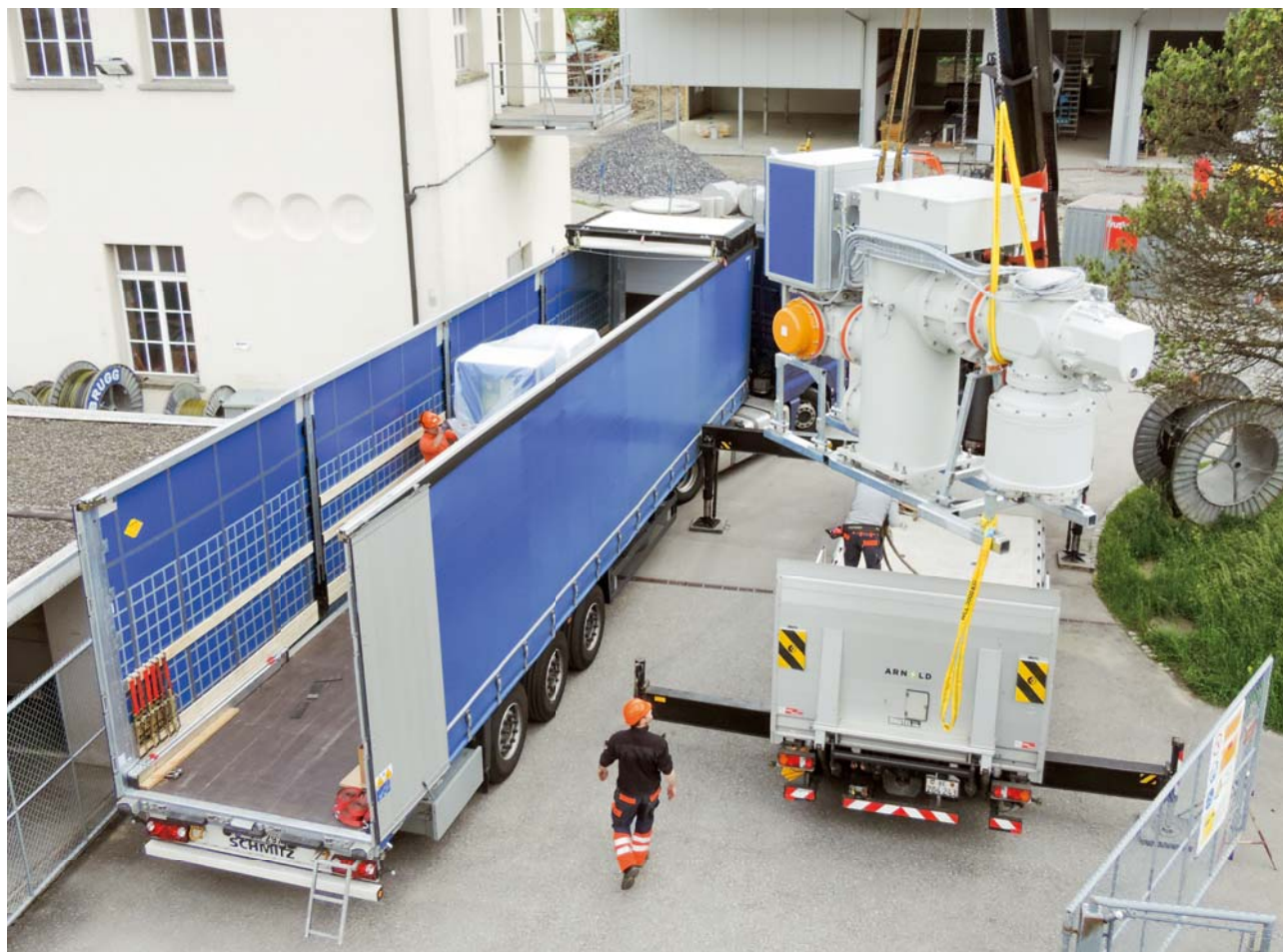
Transbordement des travées avant leur amenée dans le bâtiment.
