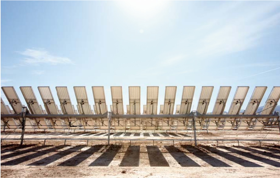
L'utilisation d'énergies renouvelables met en danger la stabilité du réseau. La variation des quantités de courant solaire injecté affecte par exemple la qualité de la tension.
