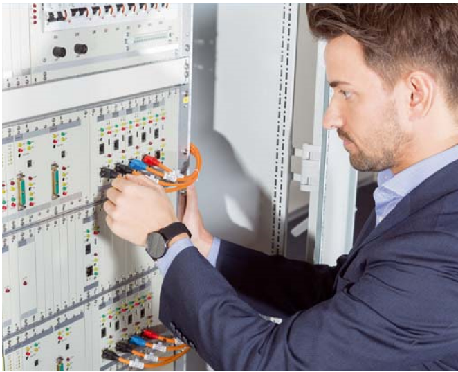
— Un régulateur de réseau P13 vu de près.
