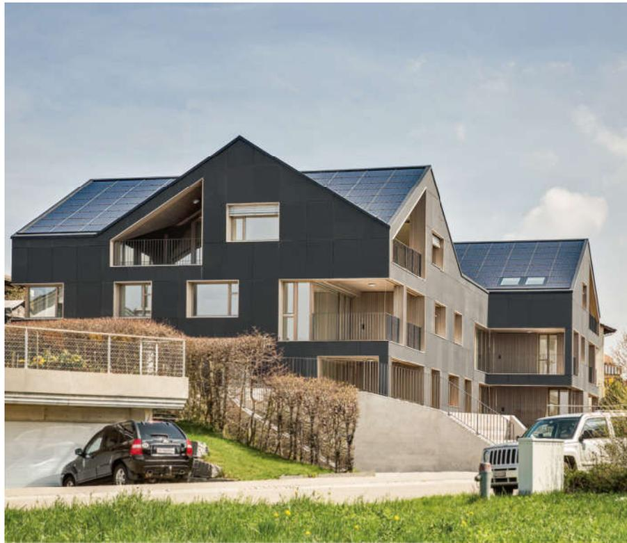
Le premier immeuble énergétiquement autonome du monde se trouve à Brütten. Toute l'énergie nécessaire aux résidents pour vivre est tirée de la lumière du soleil sur place. Des onduleurs d'ABB transforment efficacement le courant continu des modules PV en courant alternatif et l'injectent dans le réseau interne. Par ailleurs, le système d'automatisation du bâtiment ABB-free@home améliore le confort des résidents tout en réduisant la consommation d'énergie.
