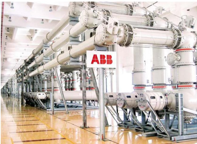
La plus grande installation de distribution isolée au  $SF_6$  sur le barrage des Trois-Gorges du Yangzi Jiang en Chine est conçue pour 550 kV.
