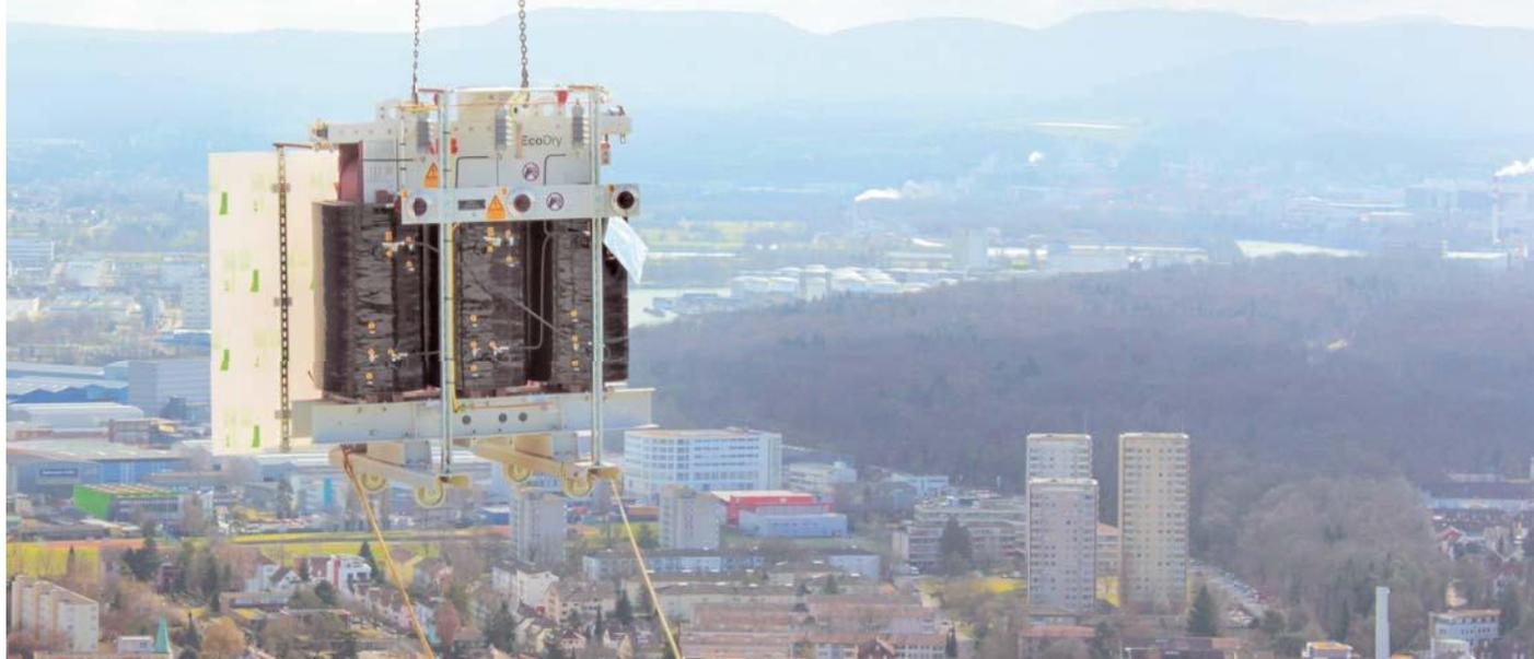
Livraison d'un transformateur au 41<sup>e</sup> étage du Bloc 1 du bâtiment Roche face au panorama de Bâle.
