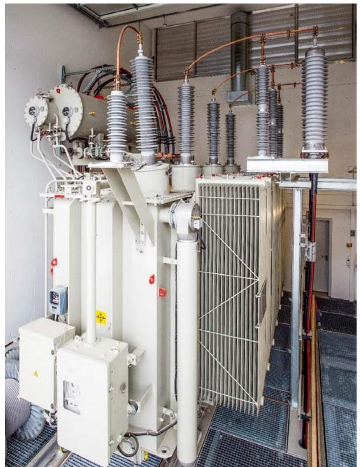
Le transformateur de 40 MVA fourni par ABB.
