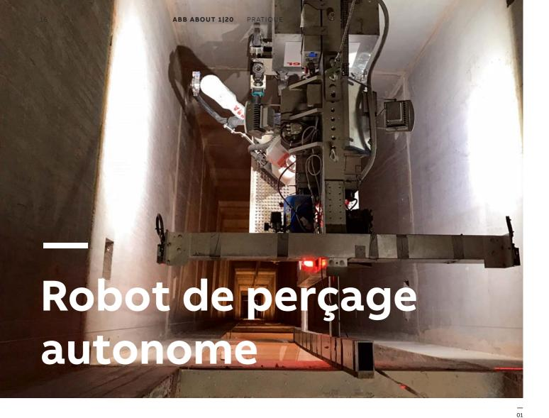
L'entreprise Schindler a développé un système d'installation robotisé automatisé et autonome pour ascenseurs dans le cadre d'un projet pilote. Pour cette première mondiale innovante, l'entreprise utilise un robot industriel d'ABB.
