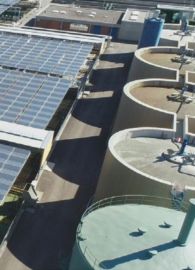
— Le premier toit solaire rétractable a été réalisé au-dessus du bassin de décantation de la station d'épuration des eaux usées de Coire. Le courant solaire ainsi produit couvre environ 20% des besoins de la SEEU.
