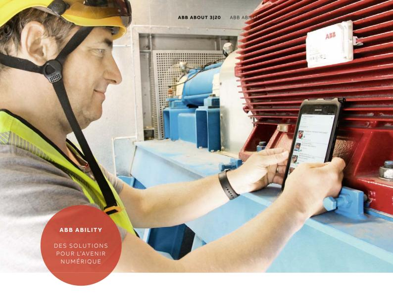
Stefan Suter voit sur la tablette les paramètres de tous les moteurs équipés d'un Smart Sensor. de classes de puissance allant de 75 kW à 630 kW dans leur usine de valorisation des déchets. Les données mesurées sont transférées dans le cloud, parfois via une passerelle, parfois via un smartphone. Elles sont analysées avec un logiciel spécifique et mises à la disposition de l'exploitant de l'installation sous la forme d'informations exploitables pour la planification de la maintenance.
